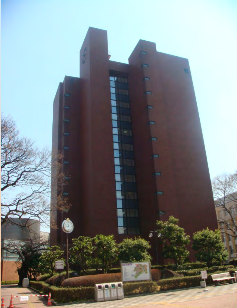
写真1. 重層構造物の一例(日大文理学部研究棟) 振動解析担当:新宮清志(1979年竣工)
