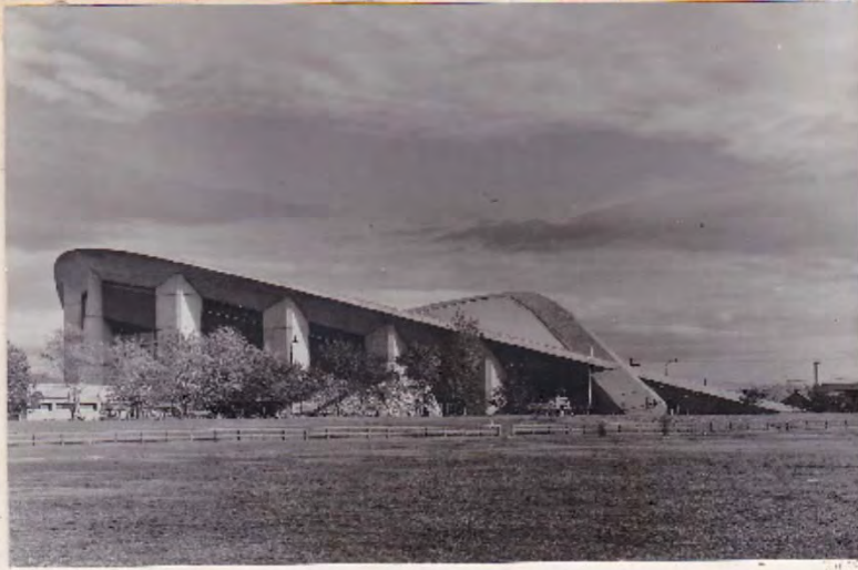
厚生年金新潟市体育館のHPシェル(スパン72m,出板厚40cm)
