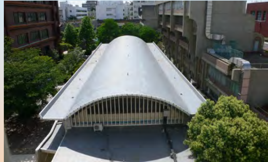
写真2 シェル構造物の一例(日大生産工学部実験棟) 構造担当:加藤渉・本岡順二郎・西村敏雄(1959年竣工)
