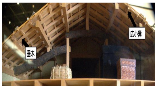
図2:復元模型の屋根の骨組み
